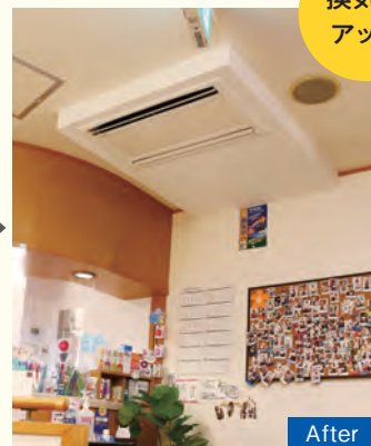
待合室に天井埋込カセット形の全熱交換器を設置し、換気量アップ。
