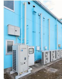
左端1台:冷蔵庫用室外機／右側4台:加工室用室外機
