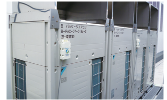
〈アシスネットサービス用IoT端末取付風景〉
