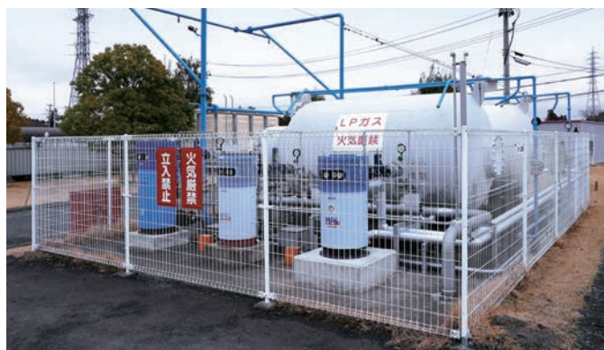
LPGバルク貯槽とペーパーライザー(気化器)
