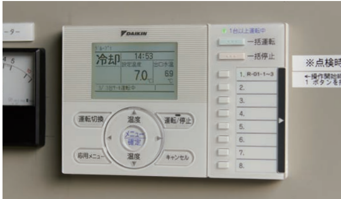
ヘキサゴンフォースの運転管理を行うモジュールリモコン。
