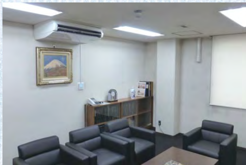
エアコンは基本的には同タイプ・同能力での更新。
