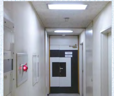
LED照明への更新で、共用部の明るさもアップ。
