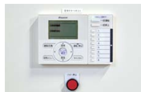
インバーターモジュールチラー3台をモジュールリモコンで制御して効率良く冷水供給
