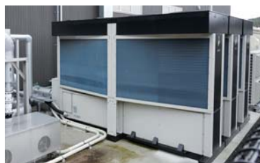
インバーターモジュールチラー3台をモジュールリモコンで制御して効率良く冷水供給
