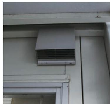
(写真左) プレハブの天井にレールを直接取付けて、露出設置形を設置しています。
