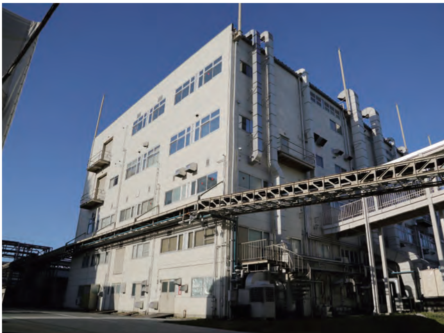
ヘキサゴンフォース32で空調する 環境試験室はこの建物の1階部。
