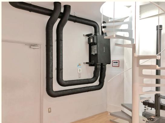
スタジオに壁付けで設置された全熱交換器。
