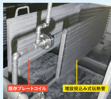
JIZAI HEAT設置後の脱脂槽内部
