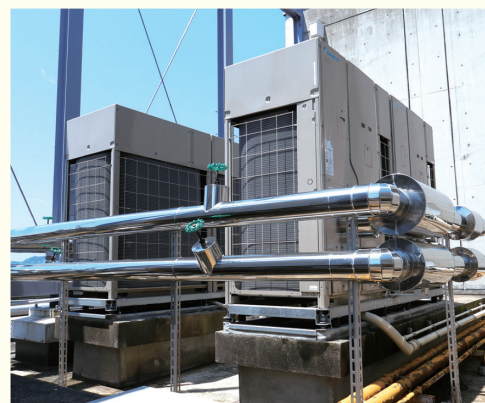
20馬力1台・30馬力3台の3系統で更新。 海に近いため耐重塩害仕様機を採用。
