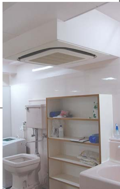
▲おトイレにもストリーマ室内機。 適正配置を重視し、梁との取り合いにもひと工夫
