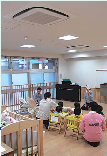
◀明るい、広々とした園内 約100㎡の空間にストリーマ室内機を4台配置。
