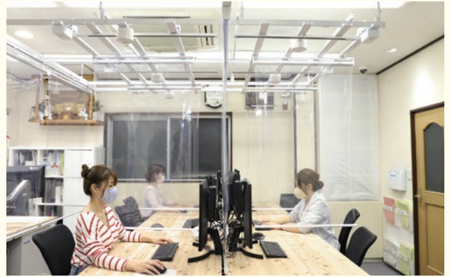
自社オフィスの中空に自社開発のクラウドスクリーン、天井部には室内機S-ラウンドフロータイプを設置。
