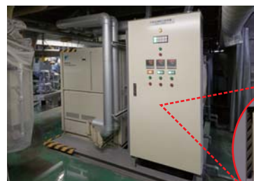
左: スタイルフリーチラー-JIZAIハイドロユニット 右: 制御盤(モジュールリモコン内蔵)
