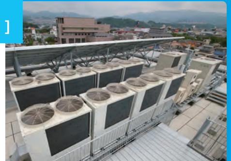
・災害時も空調と給湯、電力を確保できるよう、ビル用マルチG-up(手前)の他、給湯と発電を行うガスコージェネレーションや太陽光発電システムを設置。
