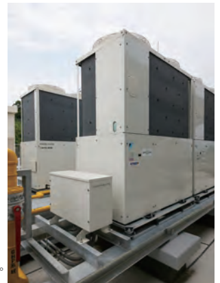
・災害時も空調と給湯、電力を確保できるよう、ビル用マルチG-up(手前)の他、給湯と発電を行うガスコージェネレーションや太陽光発電システムを設置。
