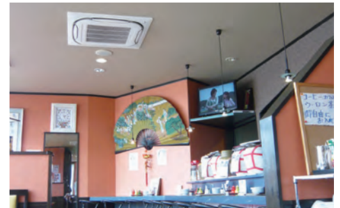
ファイブスターゼアス ラウンドフローセンシングタイプ 室内機
