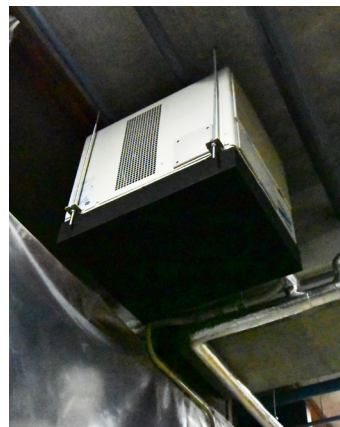
改装用チャンバーを取付け、一体型除湿機に
