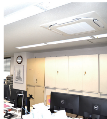
別売の「新鮮空気取り入れキット」を組み込んで外気を取り入れながらの空調で快適な室内に
