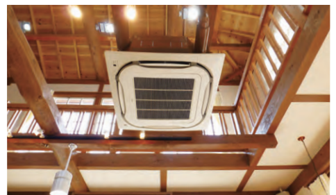
「豊田長興寺店」のエコ・ラウンドフロー<センシング>タイプ室内機。360°全周吹出しで温度ムラ解消。
