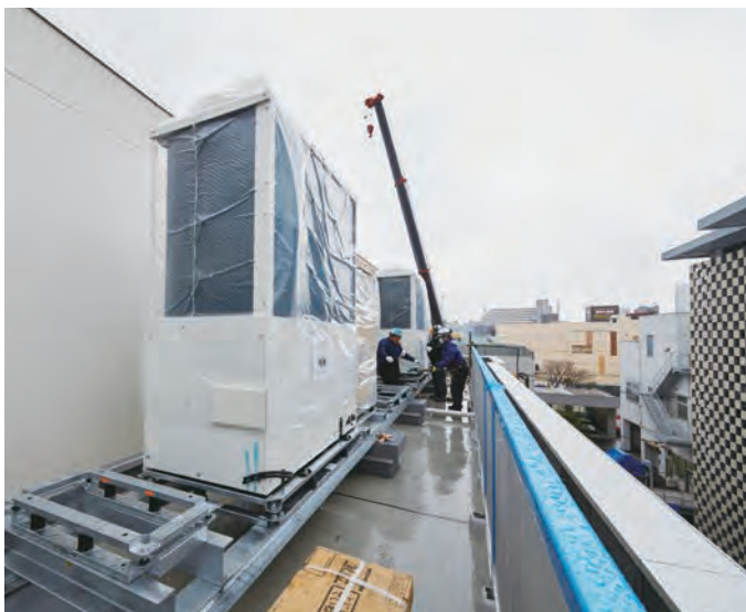
メイン配管の集約で配管スペースが縮小できるので、狭小スペースへの室外機設置も容易化
