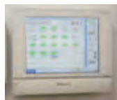
テナント様の空調料金管理を含め、2つのシステムの全てをこのインテリジェントタッチマネージャー1台で一括管理。▶
