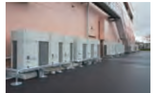
ガスヒートポンプ(左)が800馬力、電気ヒートポンプ(右)780馬力。いずれも個別空調の行えるビル用マルチタイプ。
