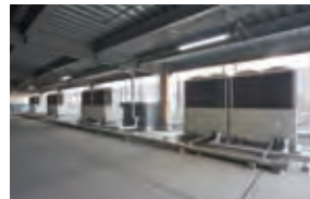
ガスヒートポンプ(左)が800馬力、電気ヒートポンプ(右)780馬力。いずれも個別空調の行えるビル用マルチタイプ。
