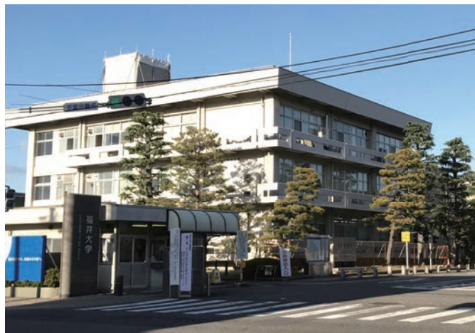
事務棟1階の事務室の空調を部分更新
