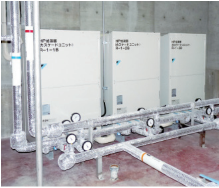
▲カスケードユニットを機械室内のタンク傍に設置。
