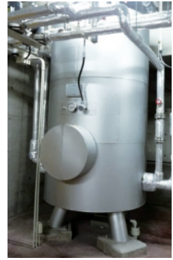
▲ポンプの搬送動力が抑えられるので、既設の密閉タンクはそのまま流用。
