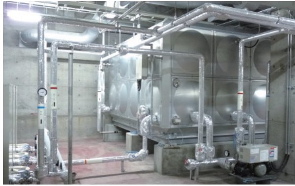
▲既設ボイラースペースに開放型貯湯タンクを設置。
