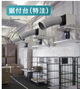
天井が高いため吊り下ろさず特注の据付台を設けて程よい高さに設置
