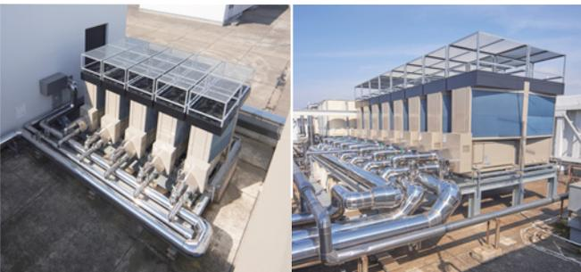
1階用(5台連続)と2階用(8台連続)の2系統に分けてヘキサゴンモジュールチラーを分散設置。
