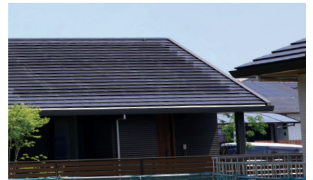
▲見た目が美しい屋根一体型の太陽光発電(8.4kW 南向き)
