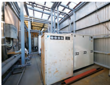
▲ライン毎に熱源機を設置。左写真の右奥と右写真の熱源機が今回更新した30馬力機種(本社工場)。
