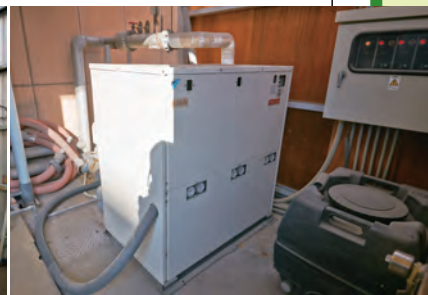
▲ライン毎に熱源機を設置。左写真の右奥と右写真の熱源機が今回更新した30馬力機種(本社工場)。
