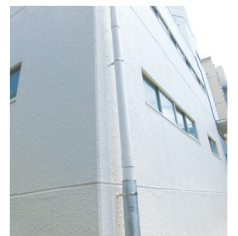
ゼッフル遮熱工法による外壁
