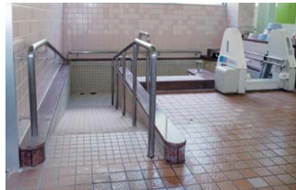
◀ 浴槽には手すりやスロープ、車椅子のまま入浴できる装置が設けられている。
