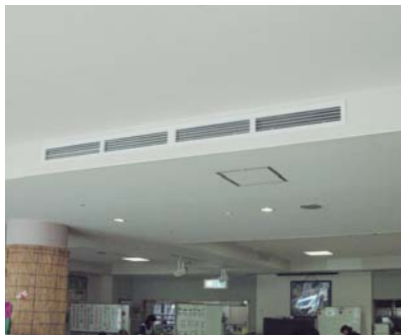
▲大広間の吹出にはダクトタイプを、廊下や居室にはダブルフロータイプを採用。
