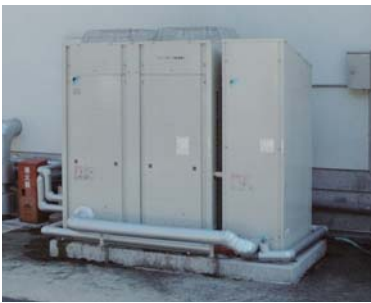
▲MEGA・Q ヒートポンプ給湯機
