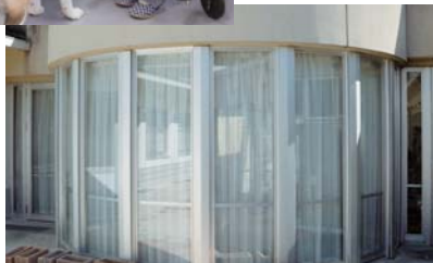
建物の断熱効果を高めるためにペアガラスを導入。
