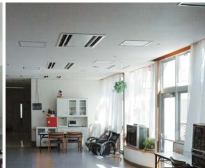
▲大広間の吹出にはダクトタイプを、廊下や居室にはダブルフロータイプを採用。
