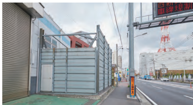
ヘキサゴンフォースを遮音壁で囲い近隣の騒音対策に配慮。
