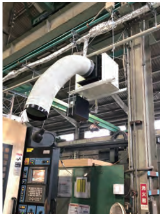
クレーンの邪魔にならないように 吊り設置で
