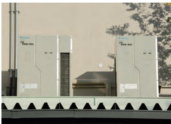
事務所エリアもファンコイルから業務用マルチエアコンに更新。
