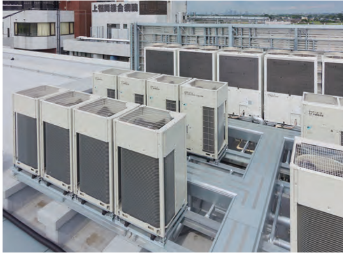
・VRV Aと組み合わせたハイブリッド空調システムを構成。
