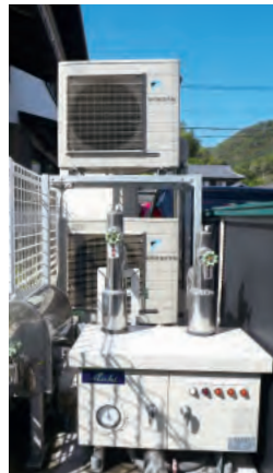
タイプ1を2台設置。食器洗浄などに使用する厨房高温水系統と手洗いやシャワーに使用する屋内循環系統に分けて使用。
