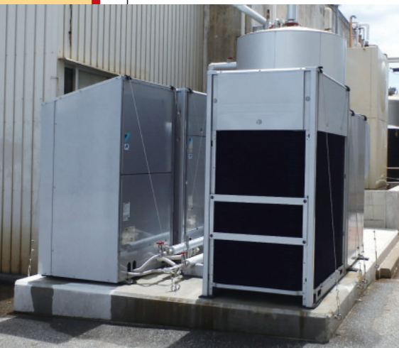
▼ 手前に2台のヒートポンプ給湯機を向かい合わせに設置。
