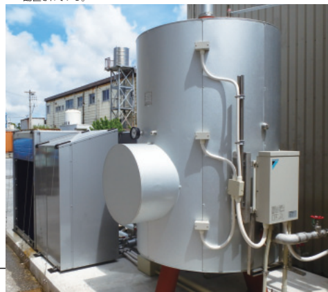
▼ タンクセンサーキットから、密閉型貯湯タンクの上層、中層、下層にセンサーが配置されている。
