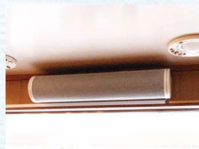
エアコンの快適性をさらに高めるための様々な用途に活用できる、ダイキンの「アシストサーキュレーター」も導入。
