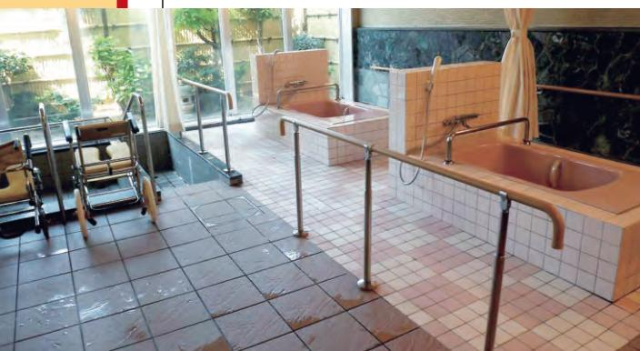
▲大浴槽の撤去したスペースに個人浴槽を2台設置。
